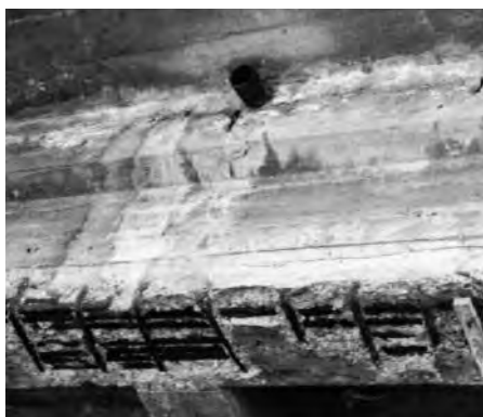
Figur 1: Avskalning av täcksikt hos en balk.
