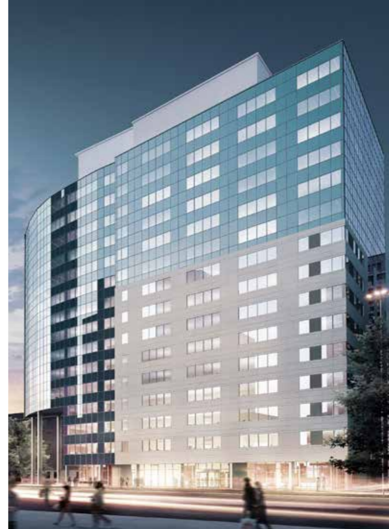
Deep Green Cooling används i kontorskomplexet Atrium 1 i Warszawa.
